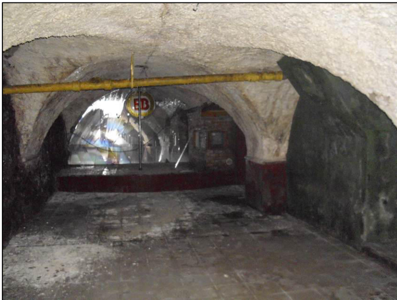
Fot. nr 5 „Część piwnicy – do pozostawienia”
