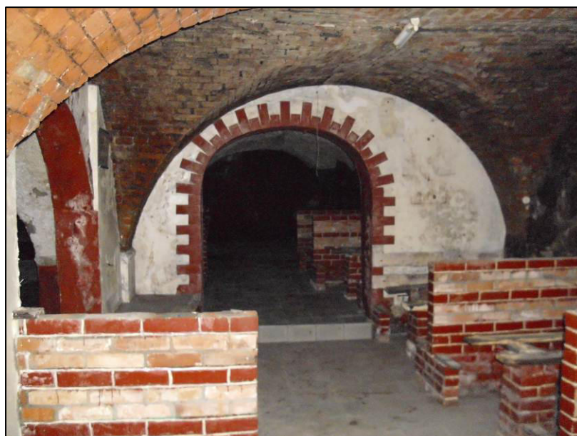
Fot. nr 6 „Część piwnicy – do pozostawienia”
