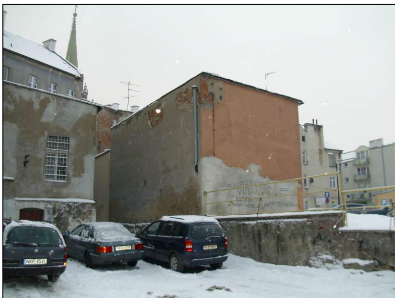
Fot. nr 2 „Widok ogólny budynku mieszkalnego – elewacja południowo- wchodnia”
