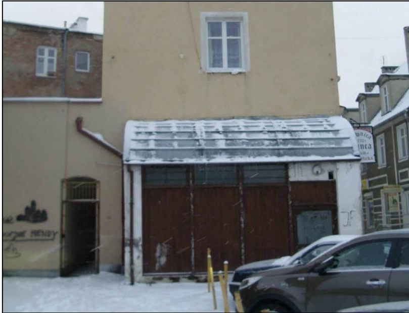
Fot. nr 4 „Zejsście do piwnicy – do pozostawienia”
