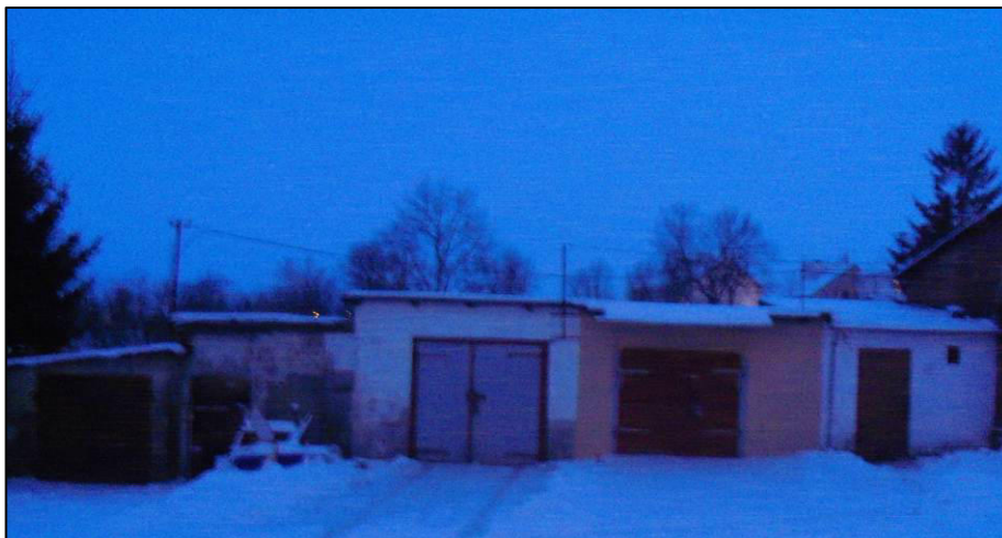
Fot. nr 1 „Widok ogólny budynków garażowych – elewacja frontowa”
