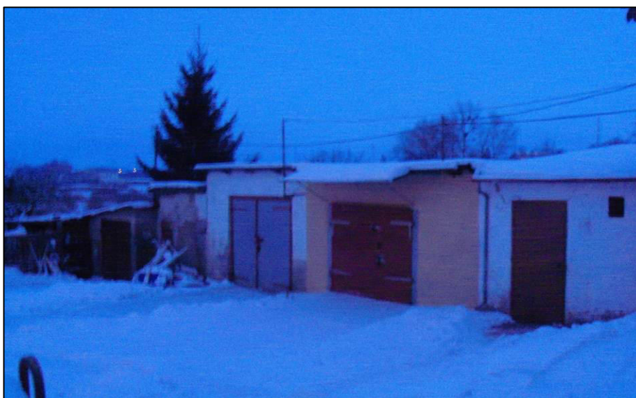
Fot. nr 2 „Widok ogólny budynków garażowych – elewacja frontowa”
