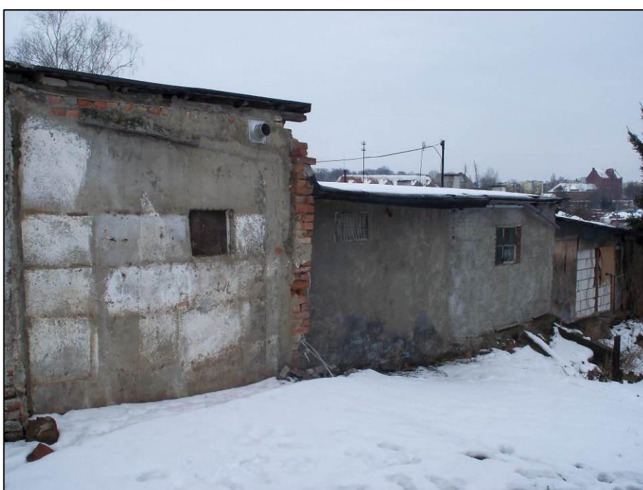
Fot. nr 3 „Widok ogólny budynków garażowych – elewacja tylna”
