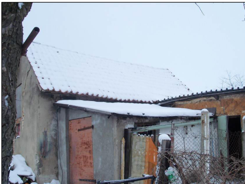
Fot. nr 2 „Widok ogólny „
