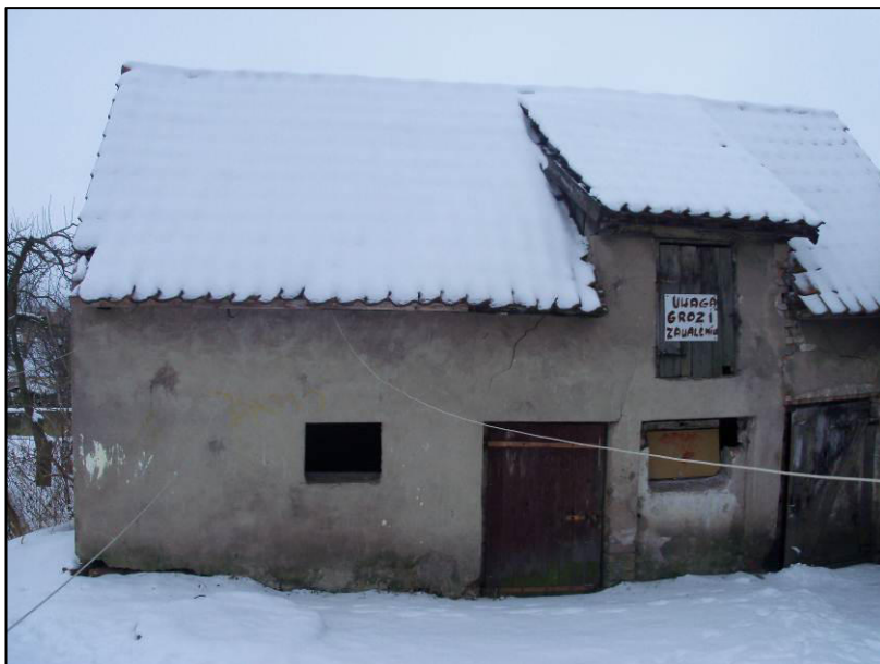
Fot. nr 1 „Widok ogólny „
